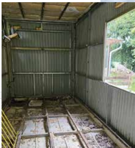
Drei damals gebrauchte Container sind durchgerostet und nicht mehr zu retten
